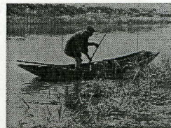
No.55 川に生きて80年 昭和41年 東村新利根川 (現稲敷市)
